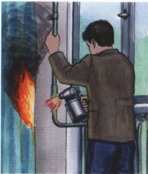
Отогревание замёрзших труб паяльными лампами и факелами, нарушение правил проведения сварочных работ
